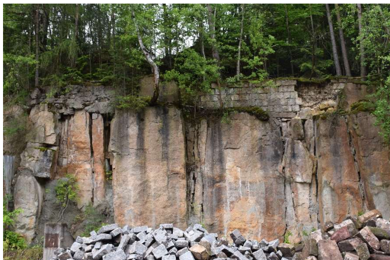
Obr. 1 Intenzivně rozpukané křemité pískovce v lokalitě Obalovna
